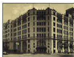
旧肥後橋本社ビル (設計:W・M・ヴォーリス)
