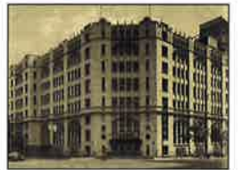
旧肥後橋本社ビル (設計:W・M・ヴォーリス)
